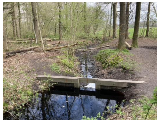
Stuwte om de afwatering van kwelwater richting de Bavelse Leij te vertragen.
