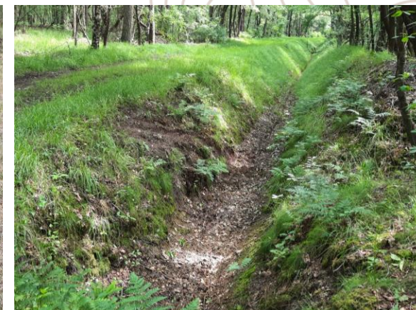
In het gebied zijn nog enkele diepe sloten aanwezig, waardoor regenwater snel wordt afgevoerd.
